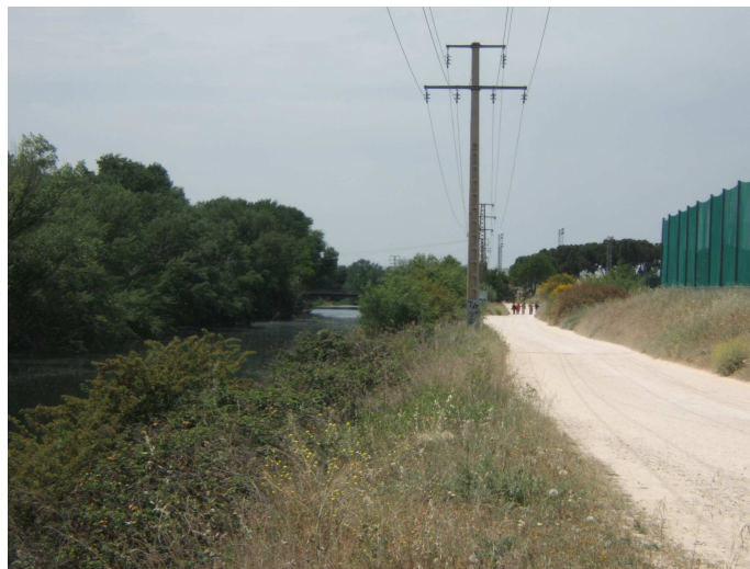
Foto 5. Aspecto del río detrás del CC La Dehesa. La línea eléctrica impide además el desarrollo de la vegetación arbórea por normativa.
