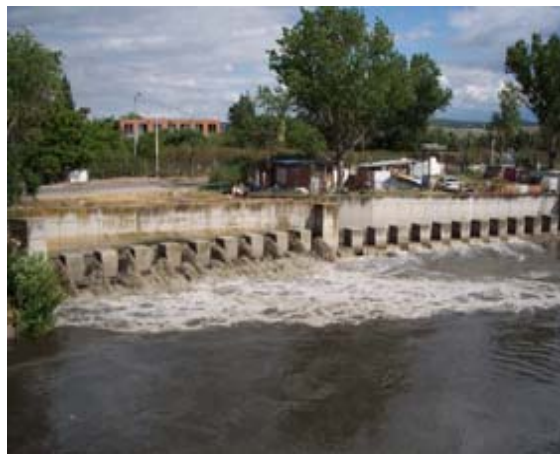
Aspecto del agua "reciclada" por la depuradora Sur
