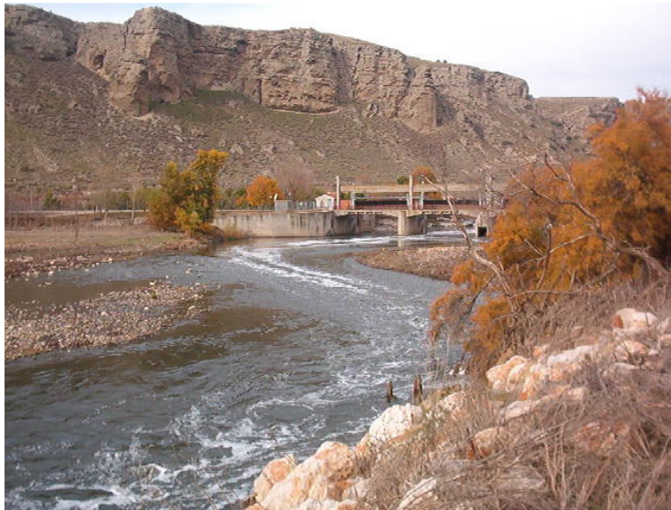
La Presa del Rey desvía al Canal Real del Jarama las aguas fecales del río para riego
