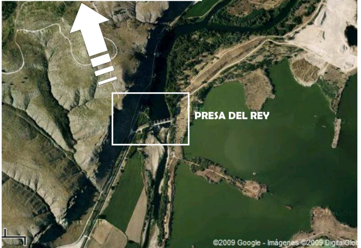
Vista aerea de la Presa del Rey y las juntas de los ríos Jarama y Manzanares
